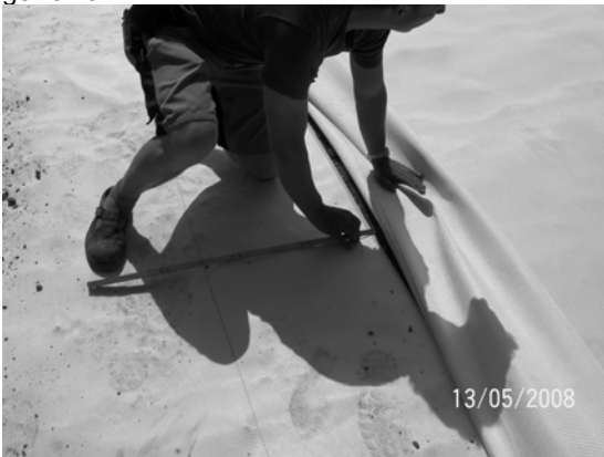
Abbildung 4.3-2 : Werkseitige Markierung der Geokunststoffbahnen zur Einhaltung der Überlappungsbreite
