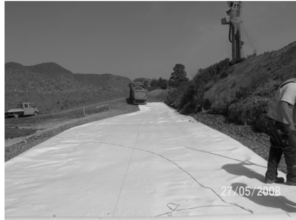
Abbildung 4-1 : Verlegte Geokunststoffbewehrung (Huesker Stablenka 1000/100)
