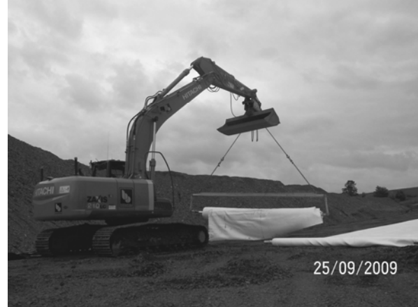
Abbildung 5-1 : Verlegung der Geokunststoffbewehrung mittels Verlegebalken
