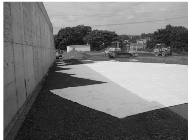
Abbildung 5-2 : Schräg verlaufende Geokunststoffbahnen im Widerlagerbereich am Bauanfang (vor Verlegung der zusätzlichen Lage)
