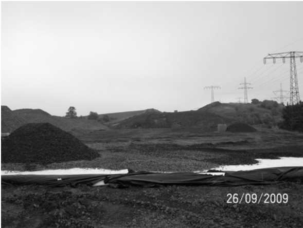
Abbildung 5-3 : Geokunststoffbewehrung innerhalb der Schottertragschicht
