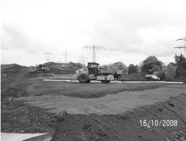
Abbildung 5-4 : Bauablauf bestehend aus Verdichtung der Schottertragschicht (Vordergrund), Einbau der bindigen Abdeckung (Mitte) und Einbau des bindemittelverbesserten Dammkörpers (Hintergrund)
