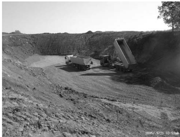
Abbildung 1-1 Ausgangssituation Restlochquerung mit Arbeitsebene im Dammaufstandsbereich
