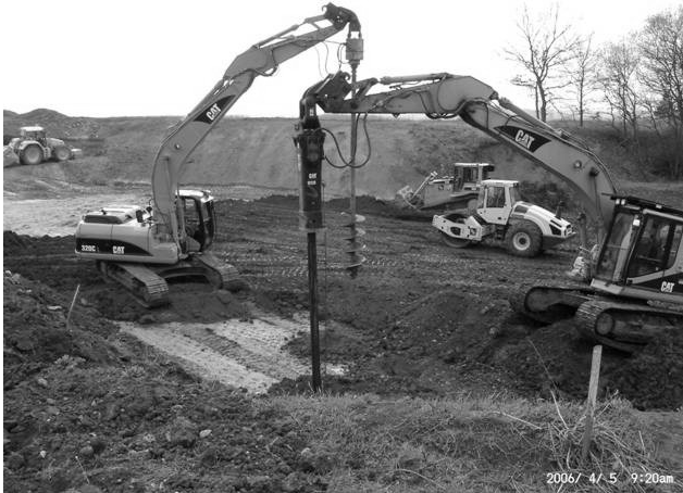
Abbildung 3.2-1 Herstellung Geopier® Bohr-Rammsäulen
