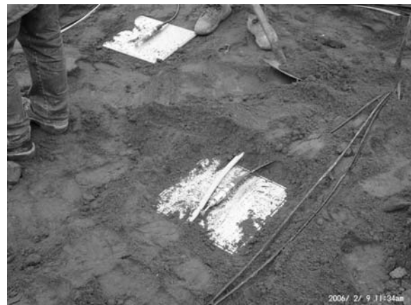
Abbildung 5.3-1 Verlegung der Erd-druckgeber
