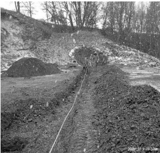
Abbildung 5.1-1 Verlegung der Messlinie des hydrostatischen Linienmesssystems im Dammaufstandsbereich
